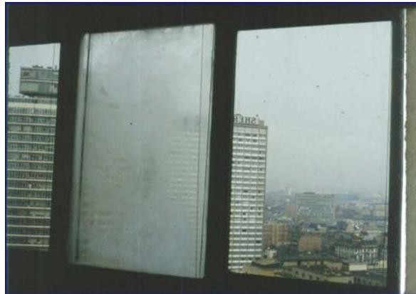
Figure 19 : Condensation sur les faces internes d'un vitrage.
