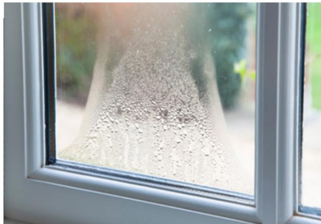
Outre les nuisances visuelles, l'isolation thermique des vitrages est généralement altérée. Les vitrages isolants dont le joint périphérique n'est plus étanche à l'air ne peuvent pas être réparés. La plupart des fabricants belges offrent une garantie de 10 ans sur l'étanchéité à l'air de leurs vitrages isolants (consulter le fabricant).
